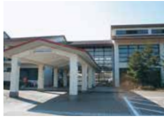
②本館入口
