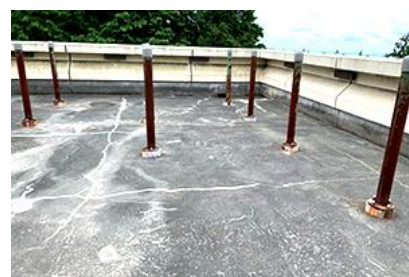
<屋上観察スペース（展望台）>
