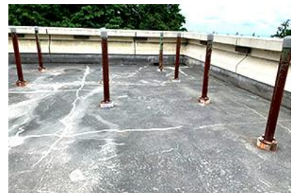
<屋上観察スペース（展望台）>
