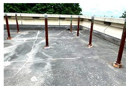
<屋上観察スペース（展望台）>
