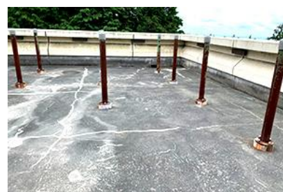
＜屋上観察スペース（展望台）＞
