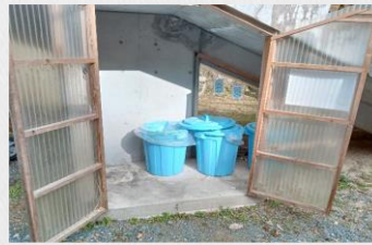
ゴミ捨て場内部
